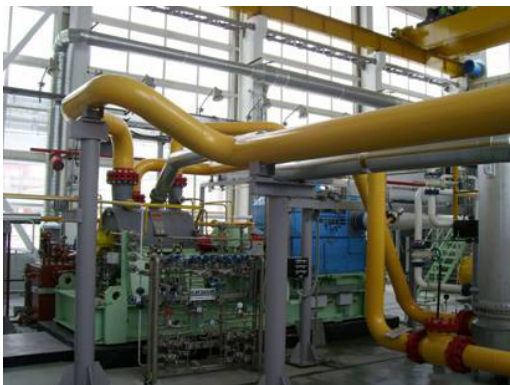
Barelový kompresor 7 RSA 44 pro stlačování směsi uhlovodíků v rafinerii nafty
