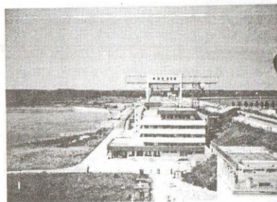
1. Celkový pohled na elektrárnu z vyhlídkové věže. V popředí správná budova elektrárny, za ní pod jeřábem všech 8 turbinových polí
