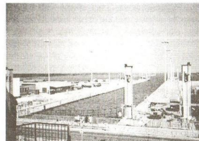
2. Pohled na část hráze s plavebními komorami a jezerem vytvořeným přehradou. V levé komoře ve směru pohledu snímku proti proudu Dunaje je hladina na úrovni horní hladiny, v pravé, částečně zachycené v okraji snímku je hladina na dolní úrovni.
