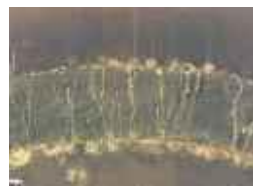
Korozní trhliny v potrubí
